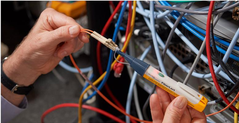
Polarität und Betrieb der Patchkabel überprüfen.
